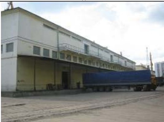
Склад № 2 с торца
