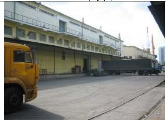
Склад № 2 с торца
