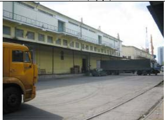
Склад № 2 с торца
