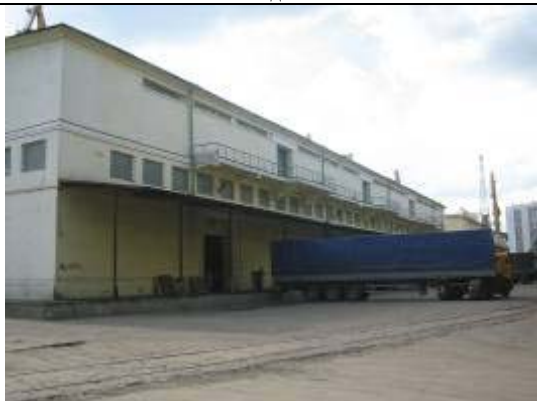
Склад № 2 с торца
