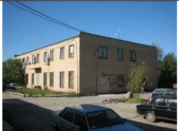
ДОЦ и бетонник
