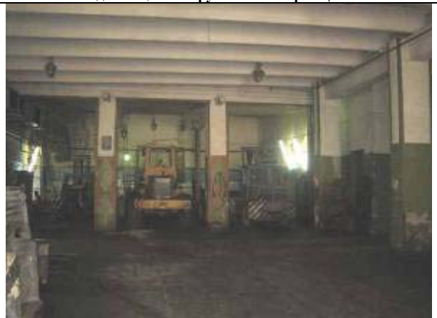
Здание цеха погрузки и конторы ЦГР
